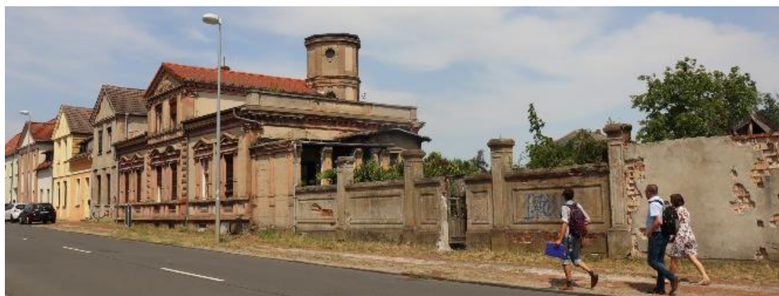
Abb. 15: Foto Luisenstraße nördlich des Bahnhofes Quelle: Foto: complan [20.07.2022]
